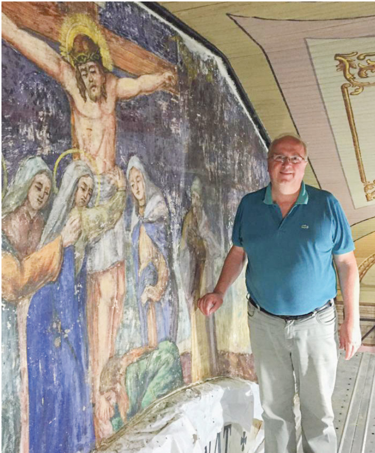
Sérgio acompanhando as obras de restauro da Igreja Matriz em fevereiro de 2016
